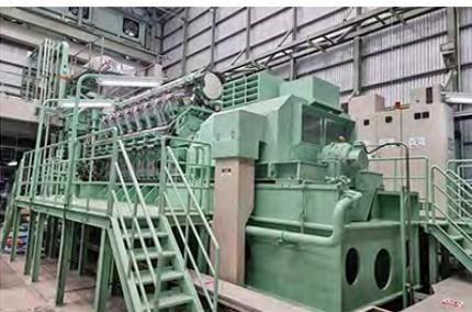
「ガスコージェネレーションによる熱電供給サービス」を評価したポイントは、まず信頼性の高い発電設備の導入によって、複数電源を確保できることです。発電設備容量は約10MW。工場で使用する電気の90%近くを賄える計算で、これなら現地の系統電力への依存を最低限に減らし、電力品質を高めることが可能になります。
