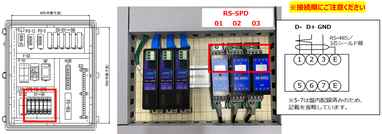
図 6-8 増設盤 RS-485 ケーブル接続位置
